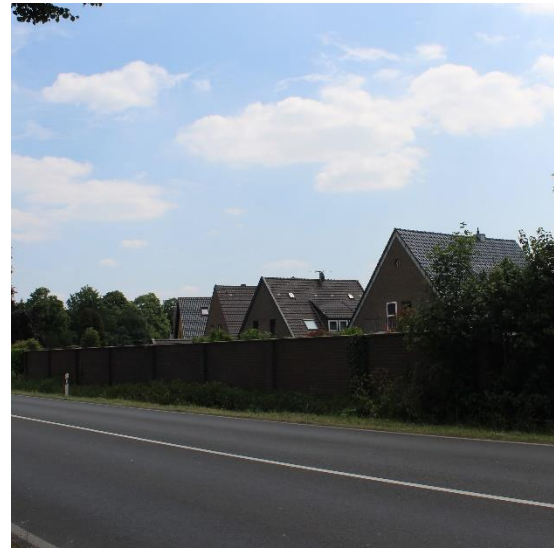
Lärmschutzwand südlich Hinsbecker Straße
