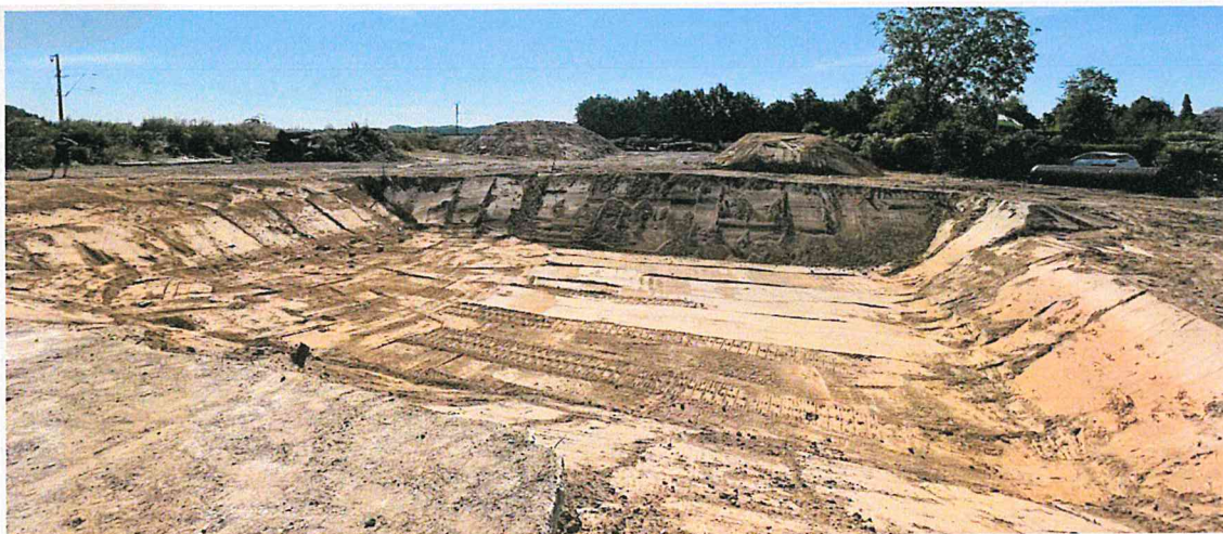
Abb. 3: Blick von der Feldstraße auf die Baugrube für das MFH. Die in der hinteren Bildmitte zu erkennende Halde beinhaltet oberflächennahe Auffüllungen.
