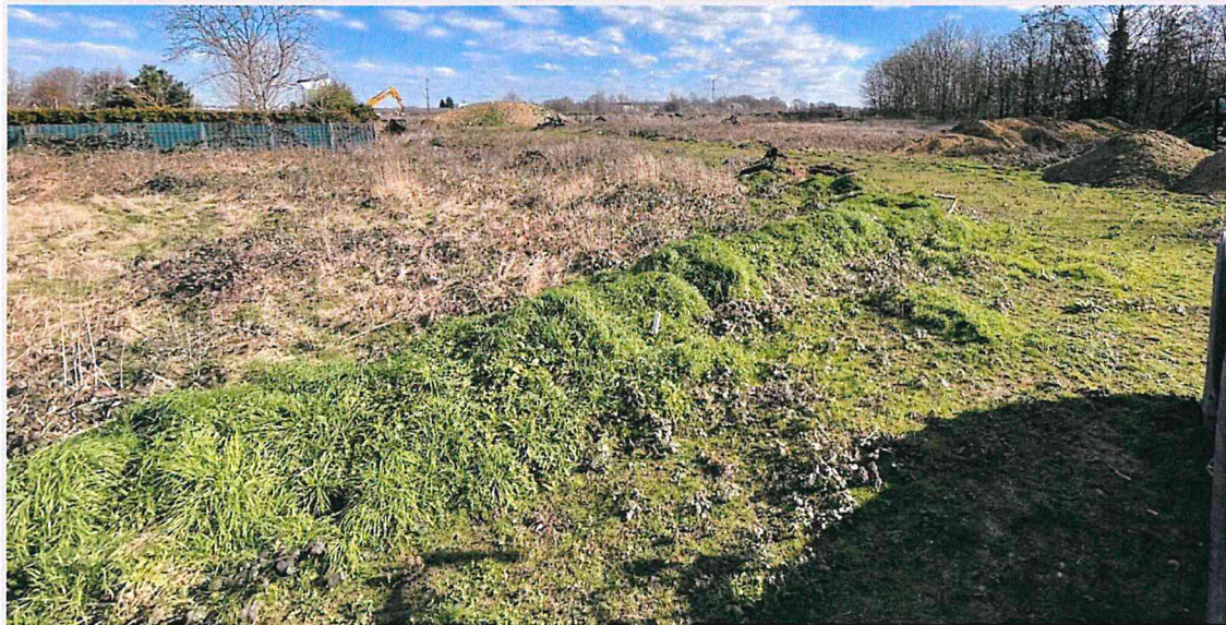
Abb. 5: Blick vom Ochsenpfehl auf das Flurstück 567. Bei den Halden am rechten Rand handelt es sich um natürlichen Erdaushub aus der Baugrube des MFH.
