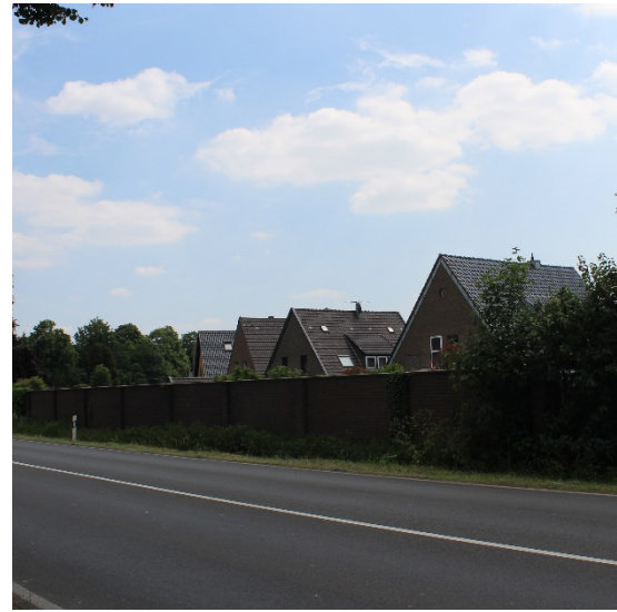
Lärmschutzwand südlich Hinsbecker Straße
